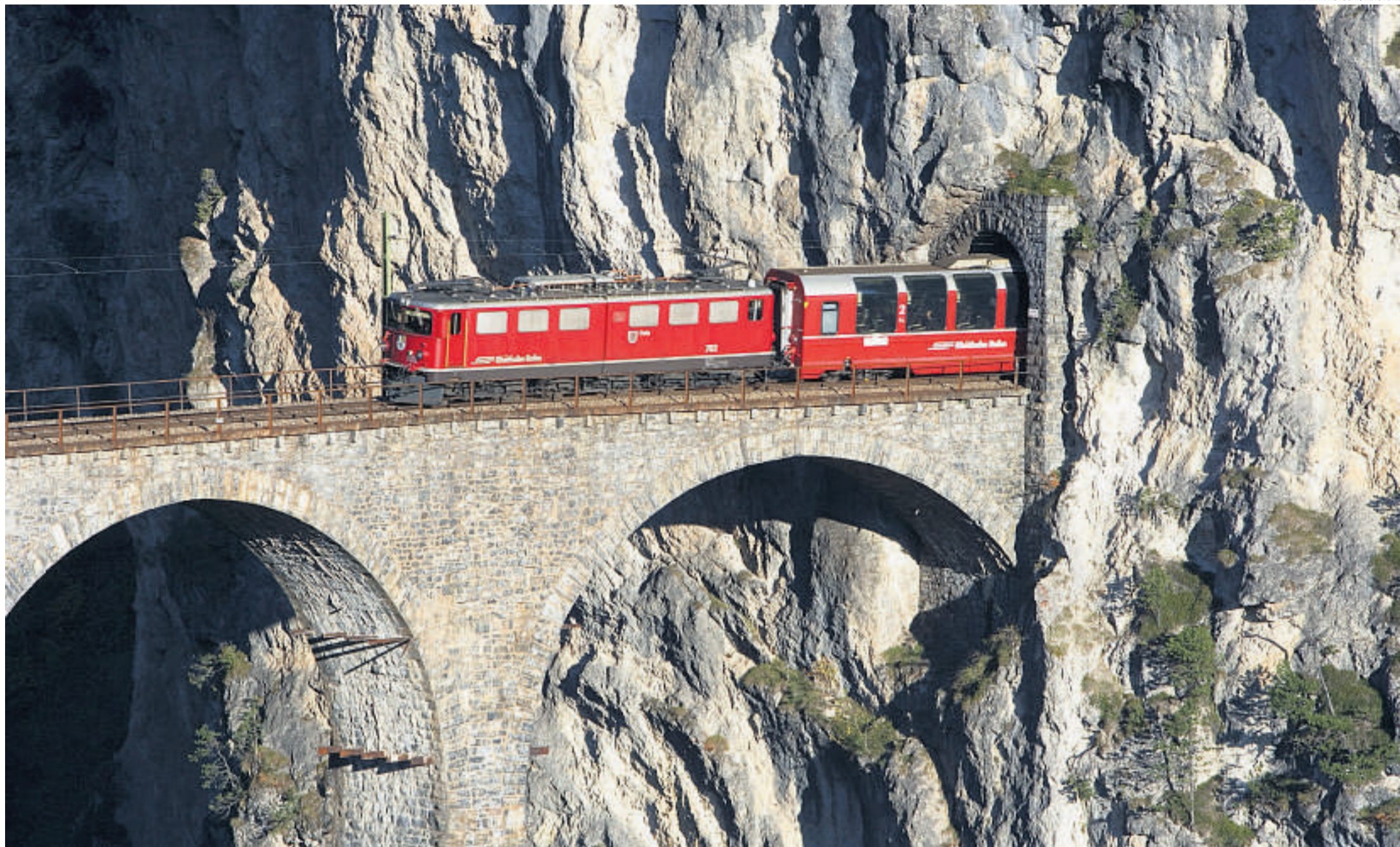
Landwassertunnel und -viadukt: Bei der Brückensanierung hat die Rhätische Bahn mit fertigen Elementen gute Erfahrungen gemacht, im Berg wird es enger und schwieriger. (2005)
