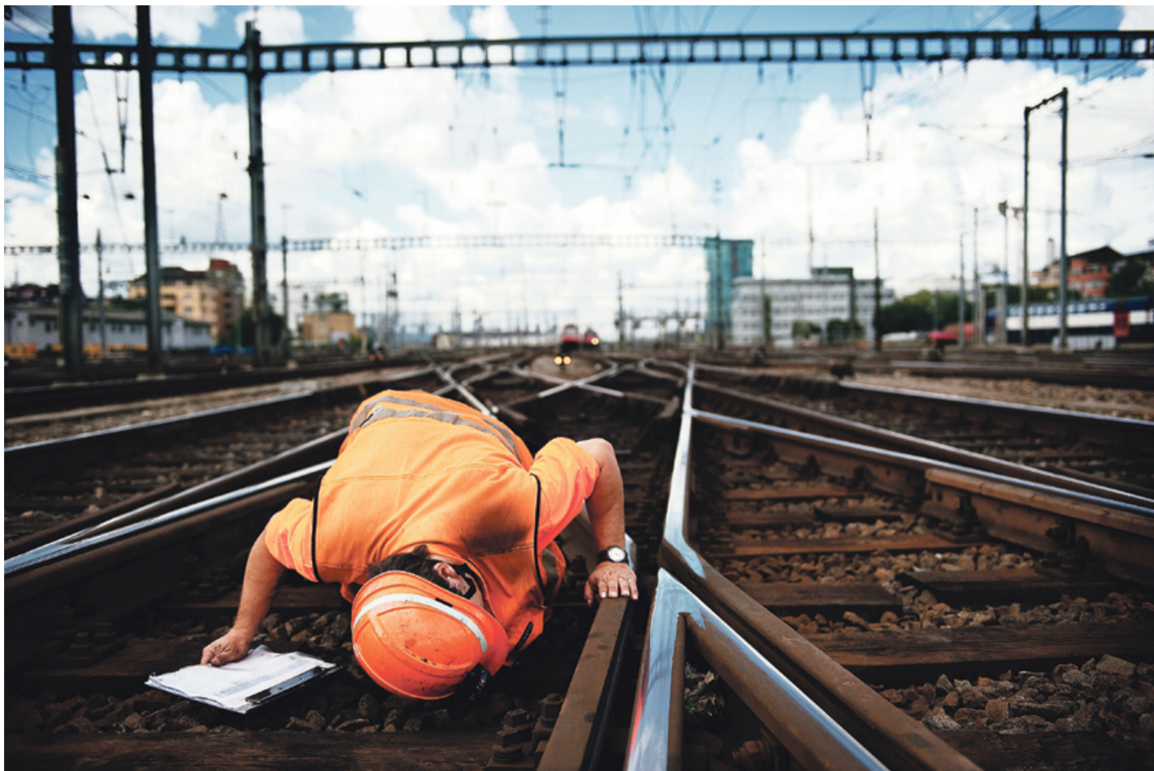
Sind nicht «sexy»: Unterhaltsarbeiten an Geleisen und Sicherungsanlagen
